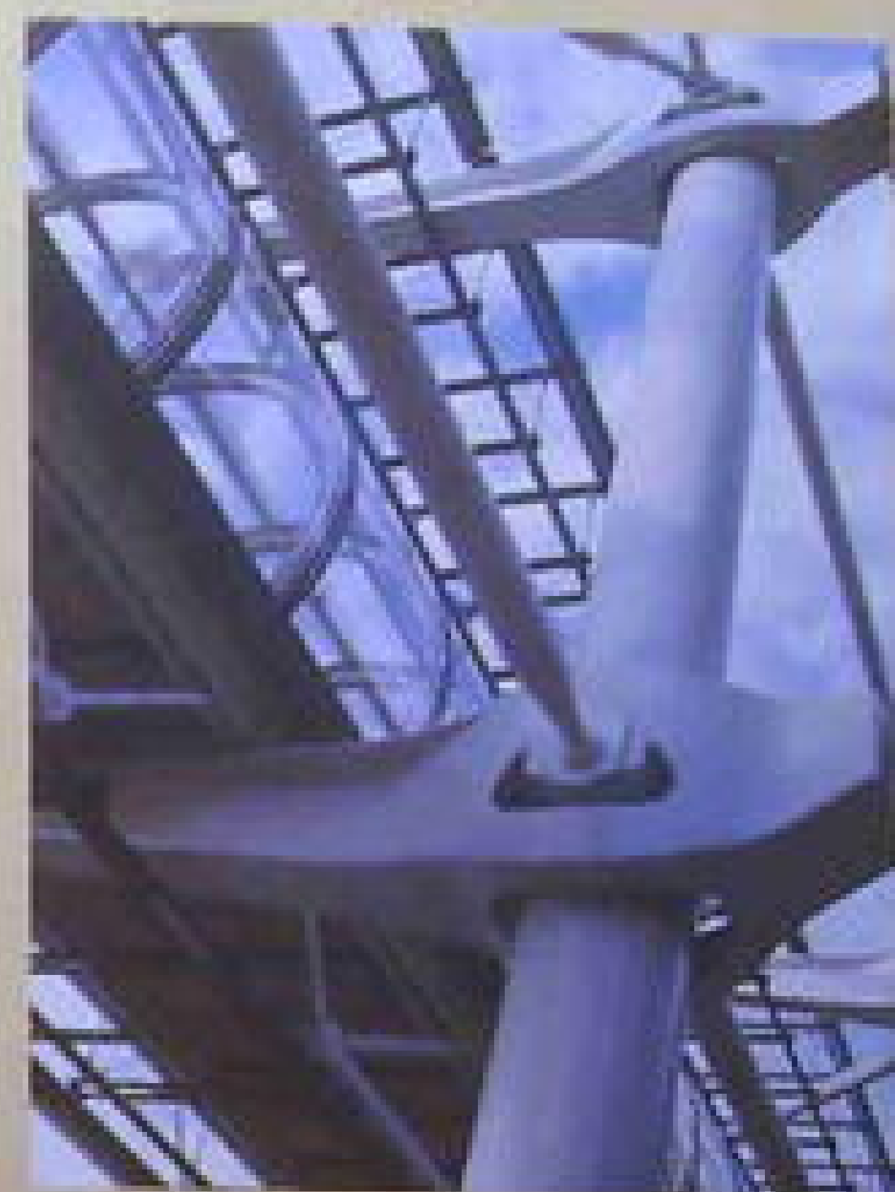
Element de suport pentru planșee și galerii de circulație a vizitatorilor. © Dominique Rappho
