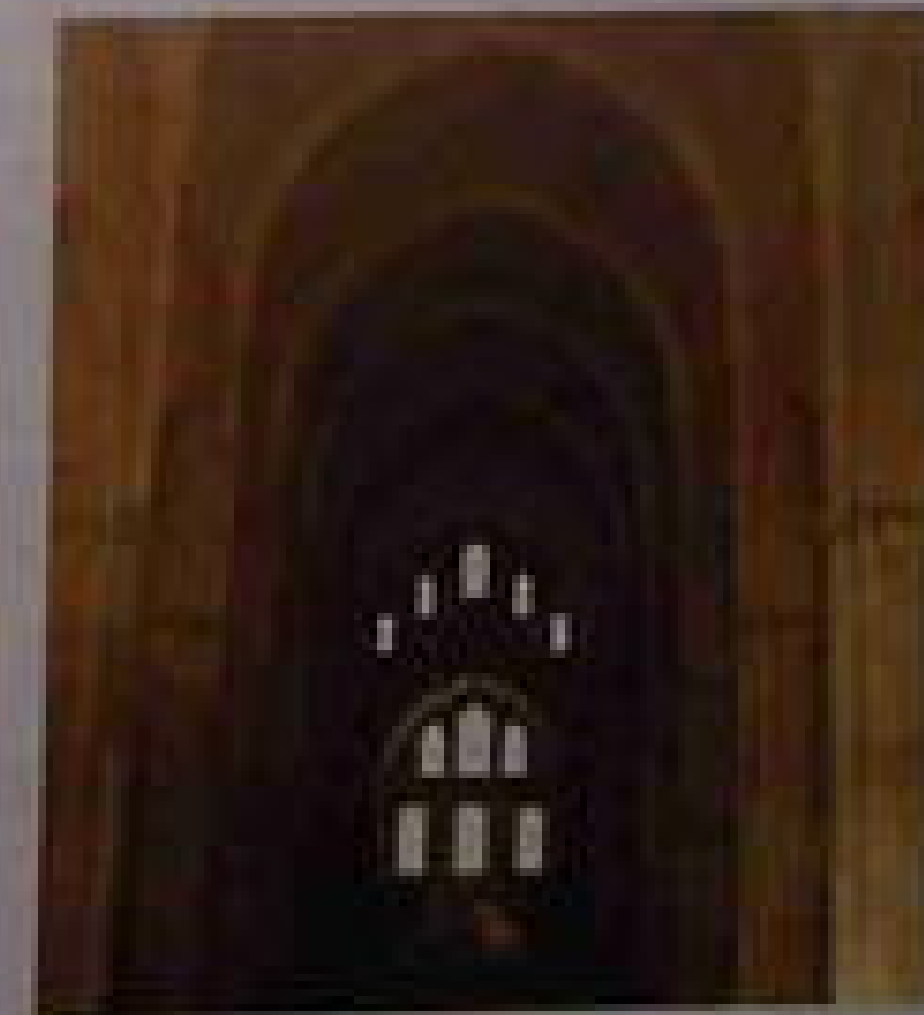
Bolta în leagăn frînt (Abatia din Fontenay). © Alain Rivière - Lecoq/TCP
